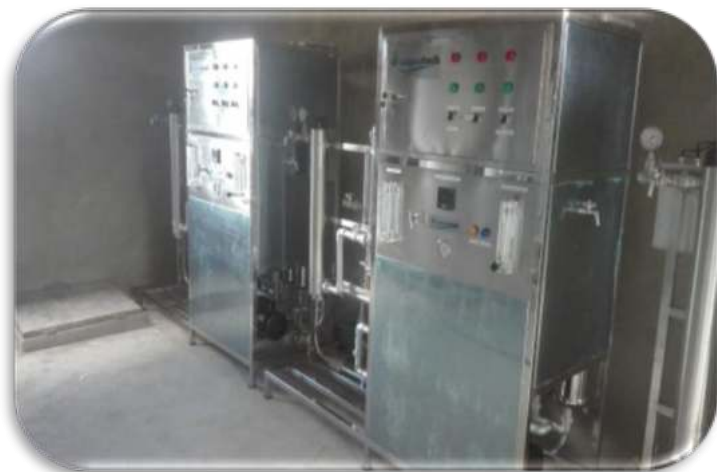
Planta de tratamiento terciario-Servicio de Hemodiálisis
